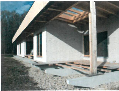
Punkt und Streifenfundamente als Betonfertigteile bilden gleichzeitig den Unterbau für die Terrassen.
