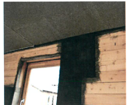
Neuentwicklung einer Lehmbauplatte aus Hanf, Lehm, pflanzlichen und mineralischen Bindemitteln erstmals eingesetzt an der Decke.
