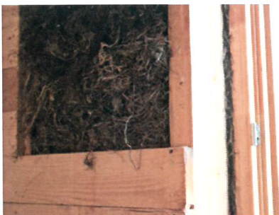
Die gesamte Außenhülle, Boden, Wand und Dach wurde mit 100 % Hanffaser ohne Zusätze gedämmt.
