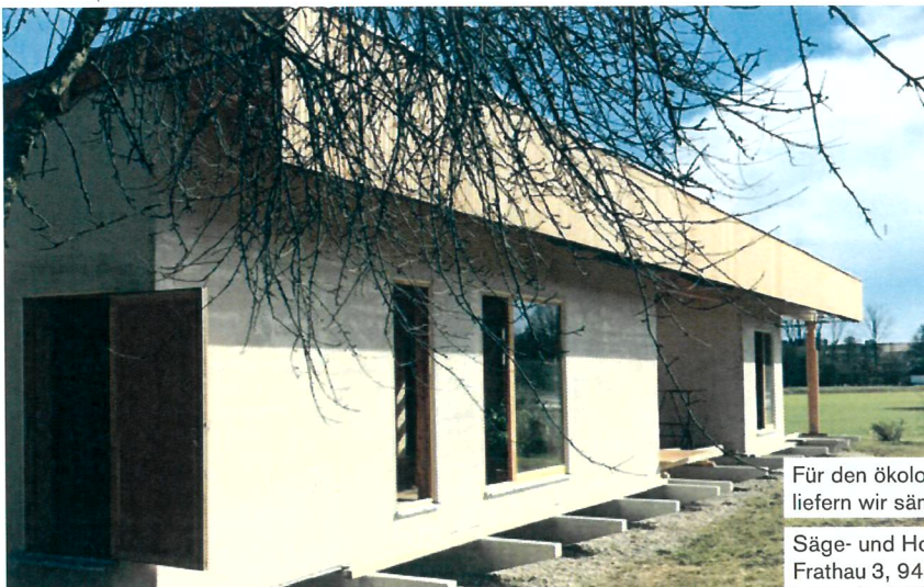
Die gesamte Außenhülle, Boden, Wand und Dach wurde mit 100 % Hanffaser ohne Zusätze gedämmt.
