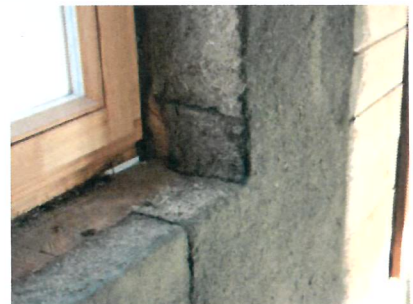
Anschluss Fensterrahmen zur Wand gedämmt mit Hanf-Kalfaterfaser.
