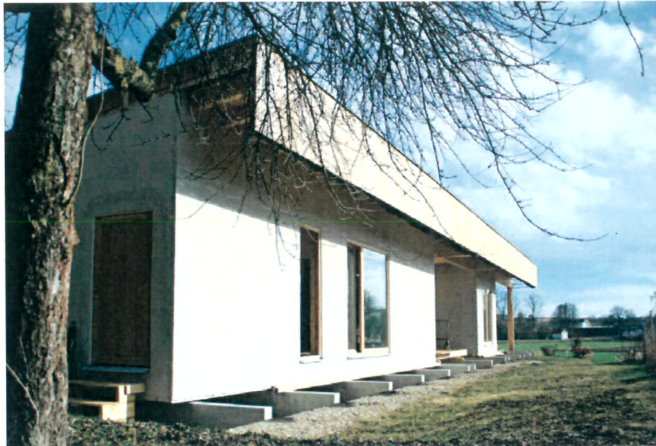
Ansicht von Nordwesten mit 1. Kalk-Putzlage und Zugangstür zum Technikraum für beide Wohneinheiten.
